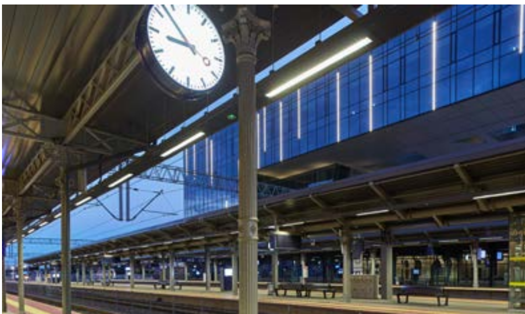
Zastosowane oprawy: Peron Line, Lampas Out
