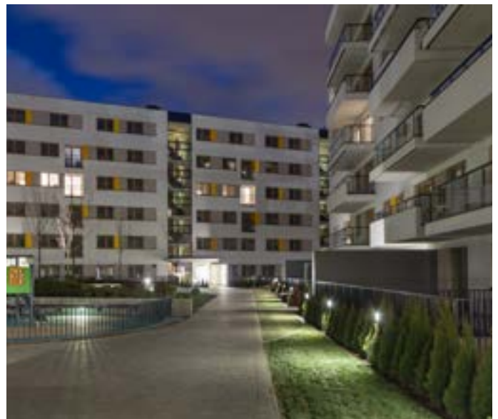
Zastosowane oprawy: Kubik Pole ODB LED
