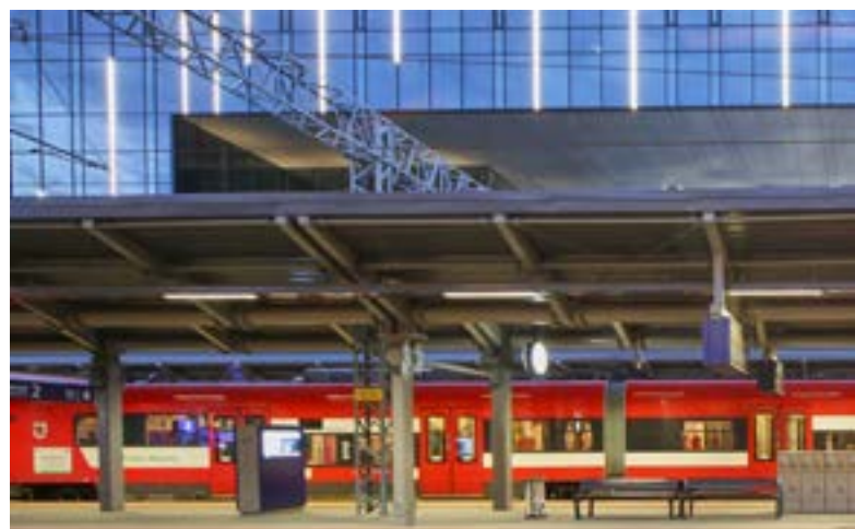
Zastosowane oprawy: Peron Line, Lampas Out
