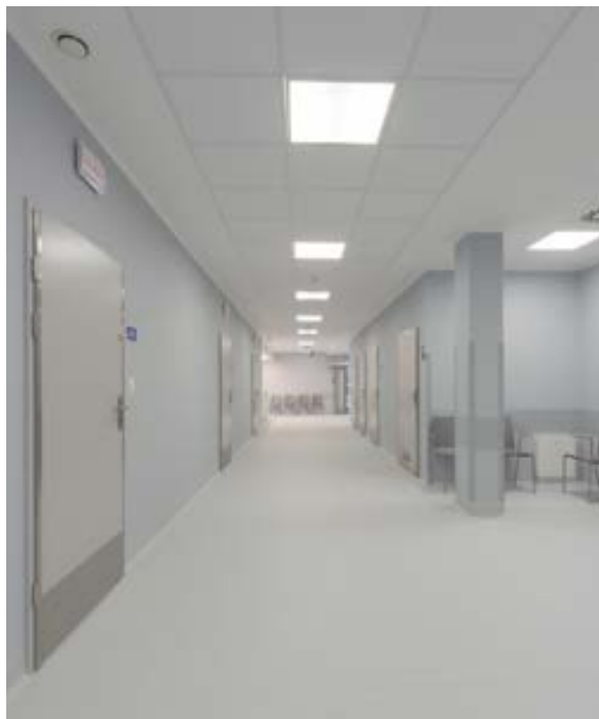
Zastosowane oprawy: Agat LED
