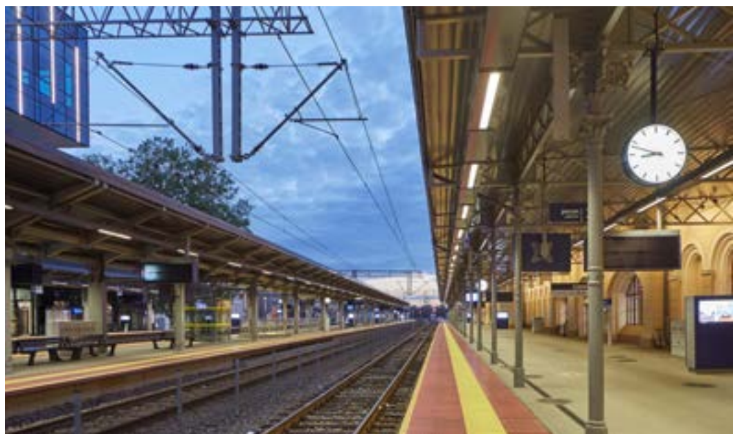
Zastosowane oprawy: Peron Line, Lampas Out
