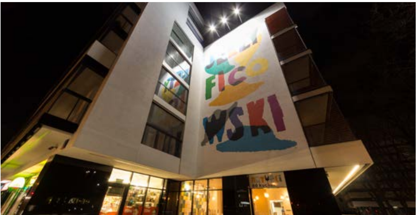
Zastosowane oprawy: X-Line G/K, Lightmotiv
