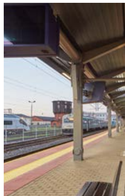
Zastosowane oprawy: Peron Line
