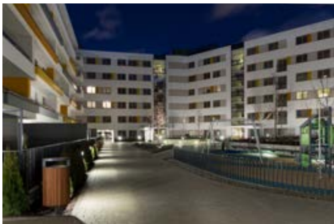
Zastosowane oprawy: Kubik Pole ODB LED
