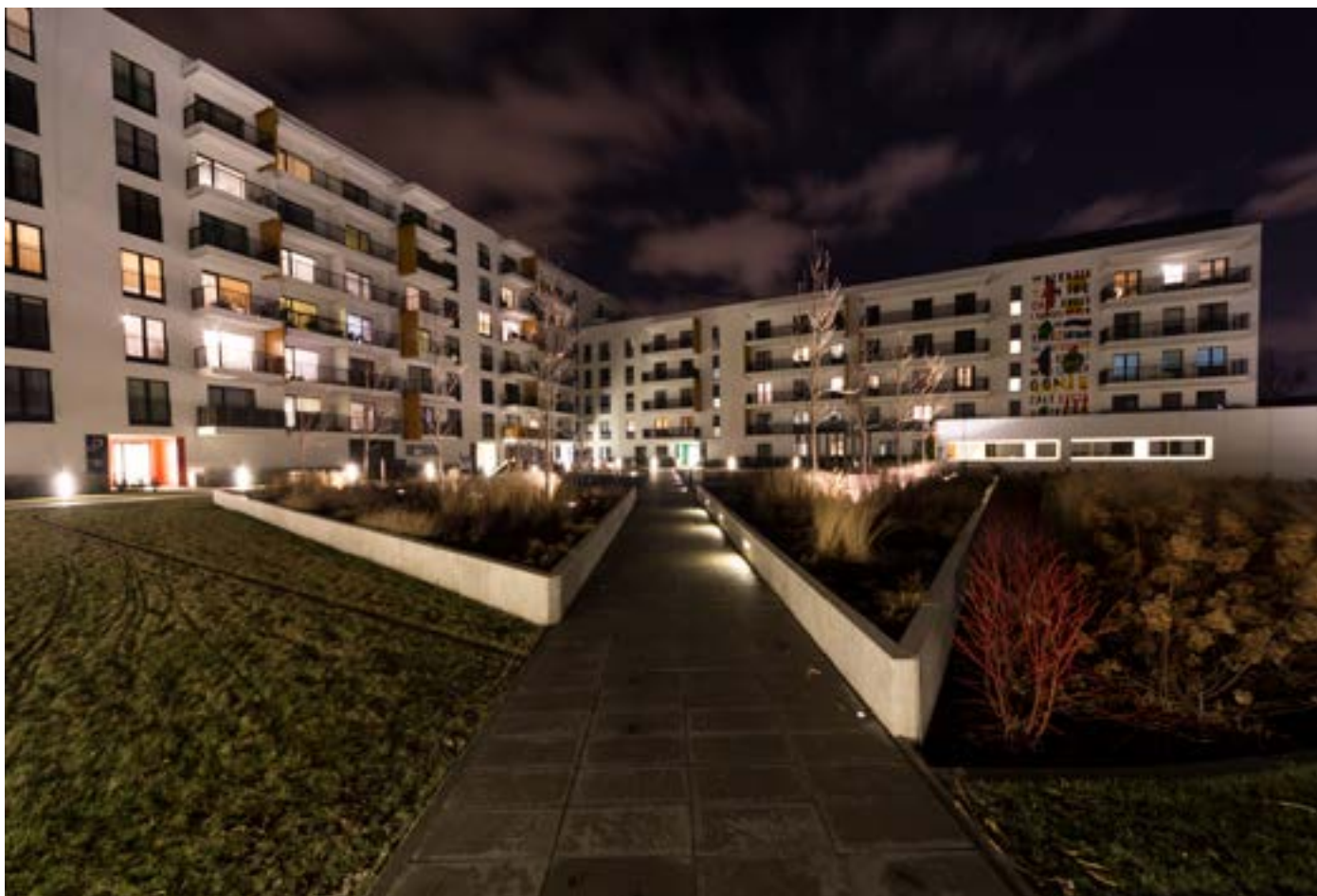
Zastosowane oprawy: Kubik LED
